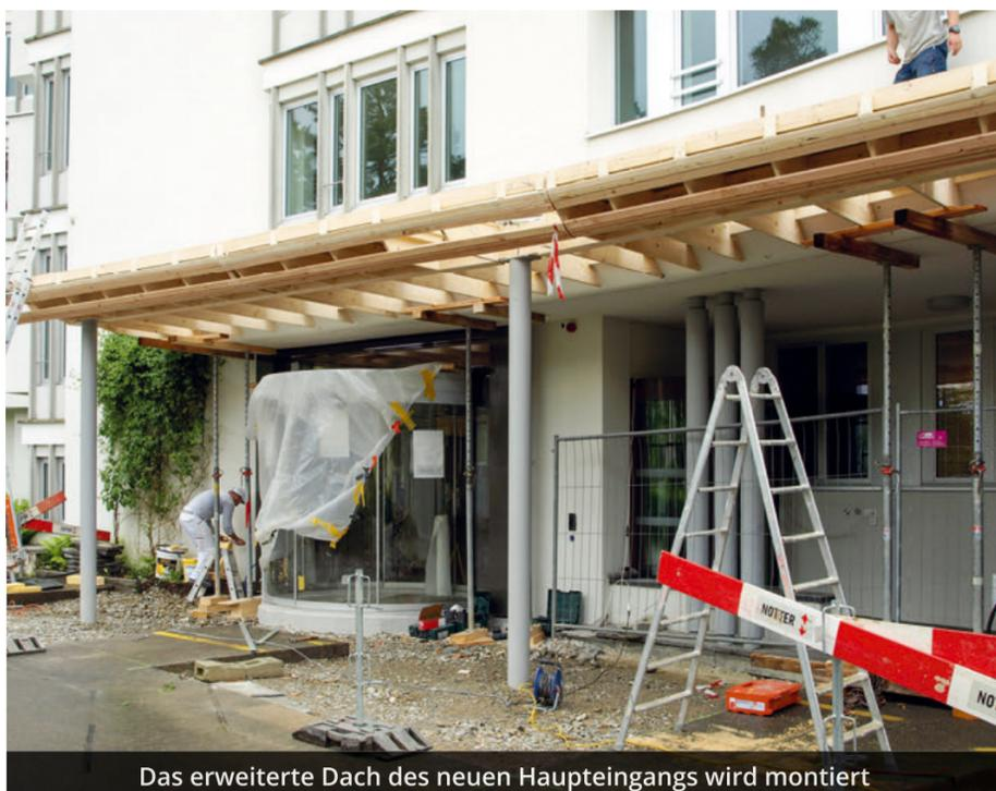
Das erweiterte Dach des neuen Haupteingangs wird montiert
